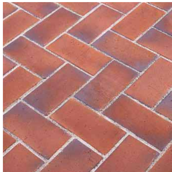
Klinker zeichnen sich durch eine besonders große Festigkeit und hohe Dichte aus.
