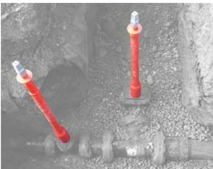
Die Signalfarbe orange gewährleistet eine sichere Handhabung im Baustellenbetrieb.
